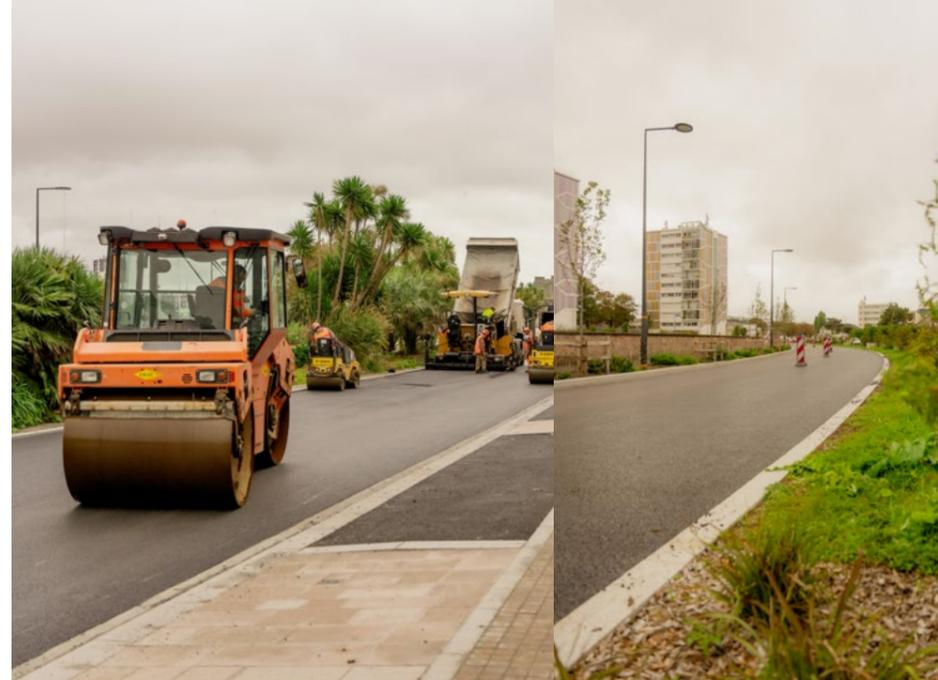
Les équipes Colas et Eurovia-Mastellotto se sont mobilisées pour une réalisation rapide des enrobés. Pas moins de 2 finisseurs ont été déployés pour réaliser simultanément les voies de circulation générale et les voies dédiées au BNG. Alimentées par des camions, ces grandes machines déposent le bitume sur une largeur bien définie et le lissent pour laisser derrière elles une chaussée parfaite.
